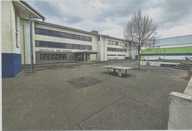
Asphalt dominiert den Hof der Schule am Giebel in Steinsfurt, laut Rektorin Susanne Amler fehlen unter anderem Schattenspendender und Spielbereiche. Diese und weitere Wünsche sollen nun verwirklicht werden. Foto: Christian Beck
