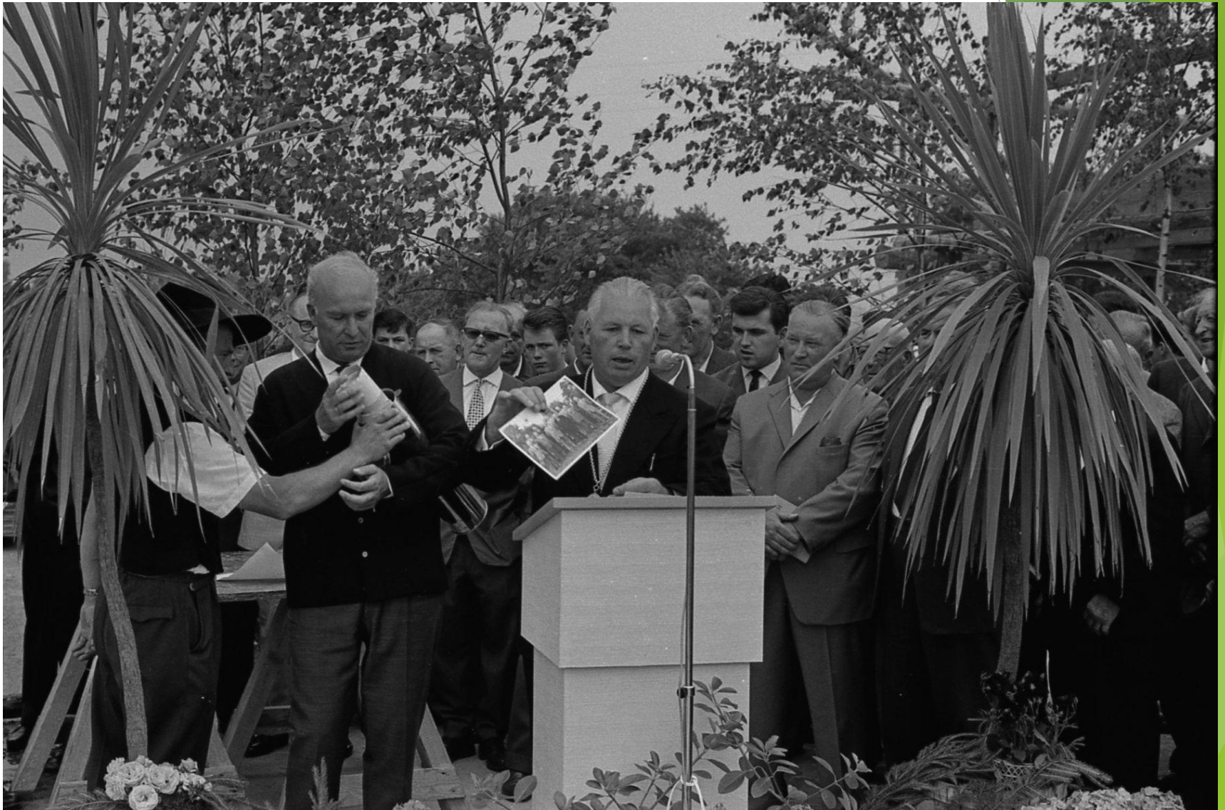
Architekt Holder legt die Baupläne in die Kartusche
